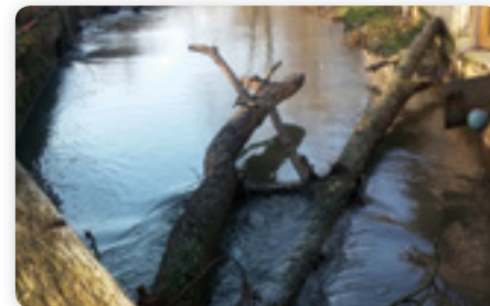
Embâcle au niveau du barrage d'Audenfort (2015)
