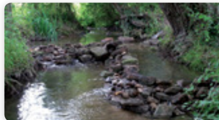
Seuil en pierres sur l'Alquines
