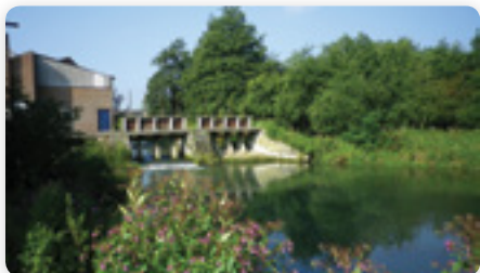
Seuil Vandroy à Tournehem-sur-la-Hem
